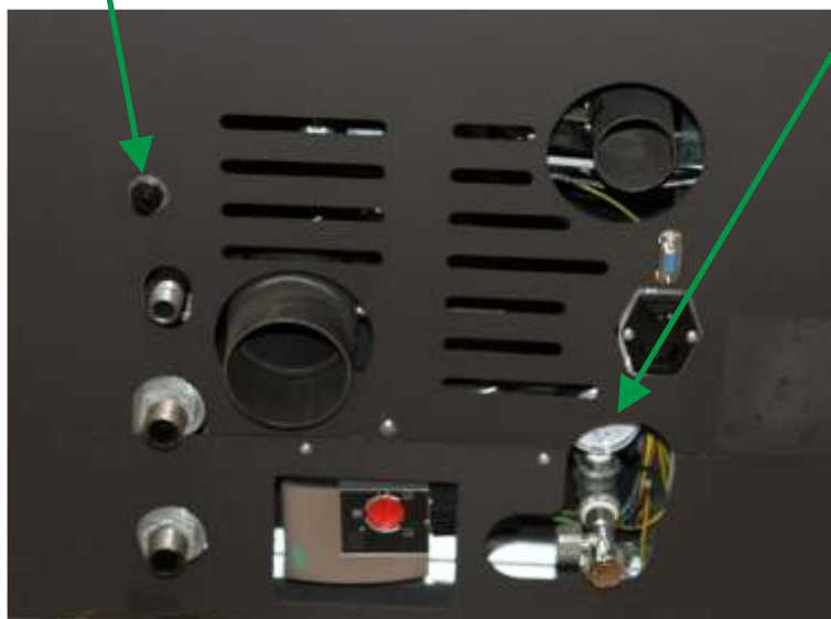
1 - Sicherheitsthermostat (STB)
